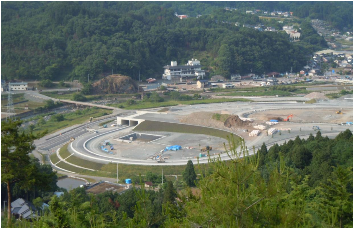
写真：八鹿氷ノ山インターチェンジ
