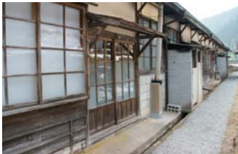
北星長屋社宅改修後（北星5号 玄関側外観）
