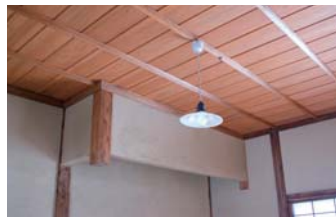
北星長屋社宅改修後（吊り床と照明器具）
