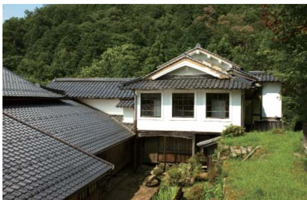
客殿 漆喰とガラス窓の外観
