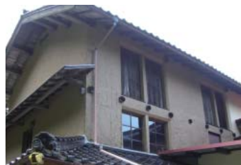
掃出し窓と梁小口
