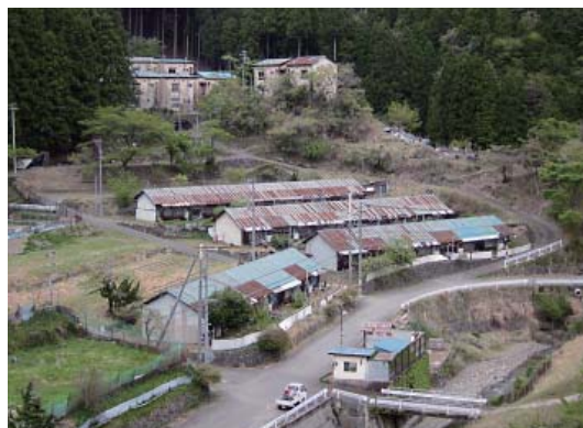
4棟の長屋と8棟のプレコンがある北星地区
