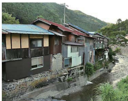
堂前橋付近の川にせり出した住宅
