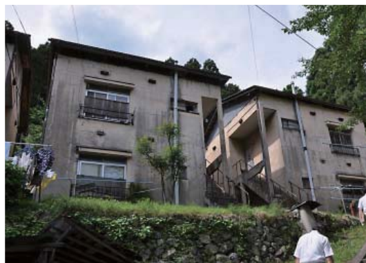
北星プレコン社宅（昭和29年建築）
