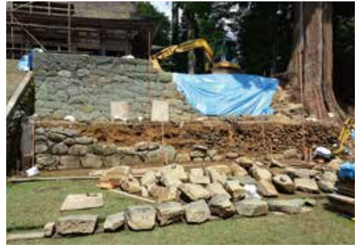
1. 石垣修理、石垣を解体して修理する
