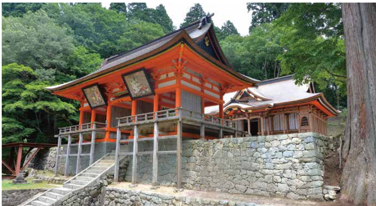
2.修理した石垣の上の当初の彩色がよみがえった拝殿と本殿
