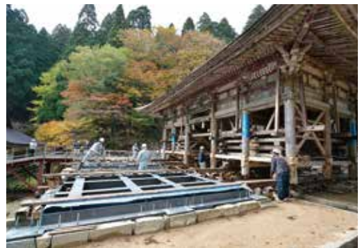
2-2. 基礎石を据直し、鉄骨架台を設置
