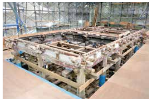
3-1. 屋根を取外し、半解体修理を実施
