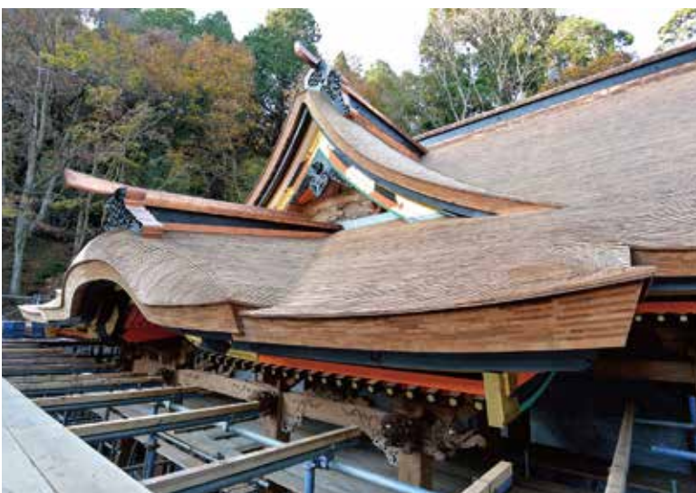
2-4. 向拝の修理完成、飾り金具は当初の銅板を補修
