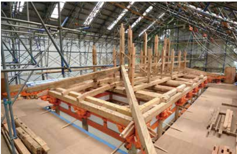
3-2. 折損した柱を取替えて屋根の組立を開始
