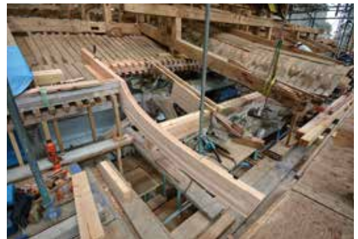
2-2. 向拝桁の補修と縫破風の取替
