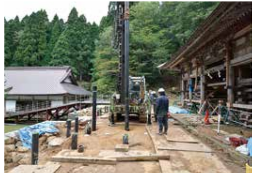
2-1. 拝殿下に鋼管杭を打設、最大深度22m
