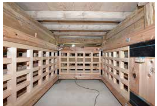
4. 床下を補強し、格子組の耐震壁を設置
