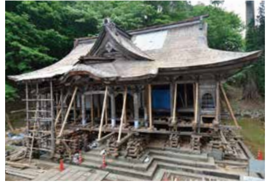
1. 揚屋工法で本殿を持ち上げる
