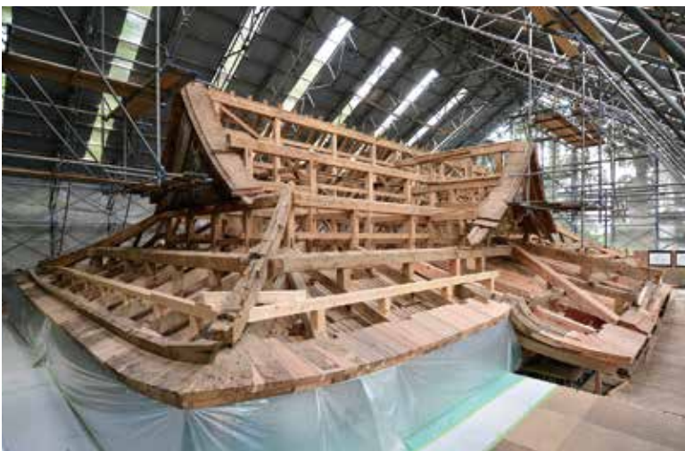
2-3. 小屋組の組立状況（周囲を仮設建物で覆った中で修理）
