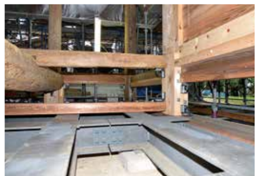
4. 床下に補強材を取付けた耐震補強
