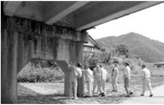
▲市役所前の新町橋を調査
