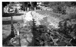
▲大谷川の氾濫による市道の崩壊（中米地）
