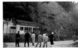
▲山崩れによる民家への土砂の流入（八鹿町岩崎）
