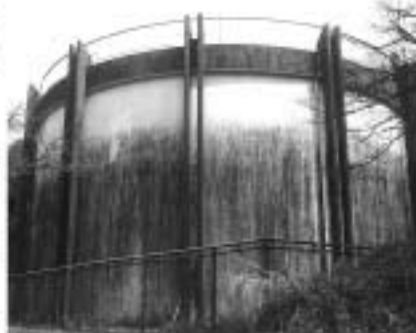
▲ 市内の上水道施設（上綱場配水池）
