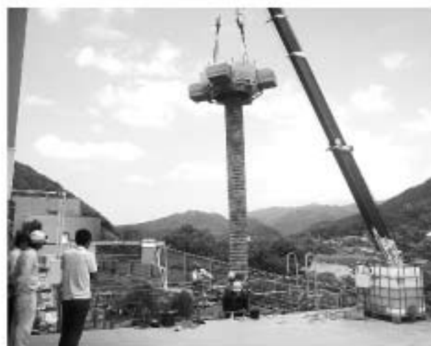
▲八歳浄化センターの長寿命化工事
