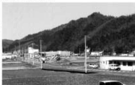
建設中の大型商業施設 (朝倉地区)
