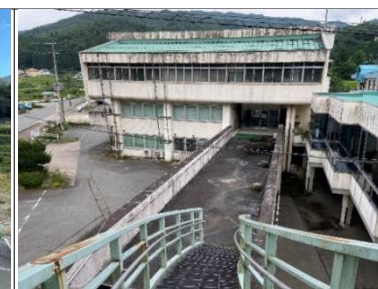
写真3 旧関宮地域局庁舎
