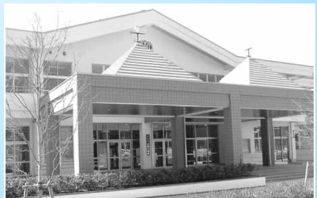
本年 4 月に開校した統合・建屋小学校
