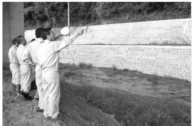
河川に堆積した土砂の状況を確認
