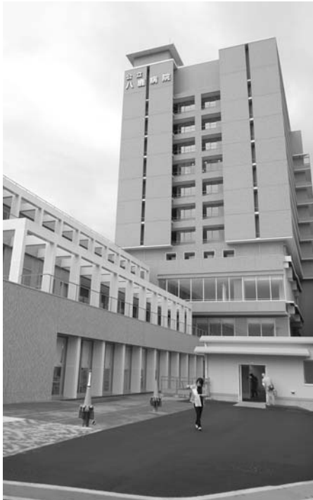
最新の設備を備えた公立八鹿病院
