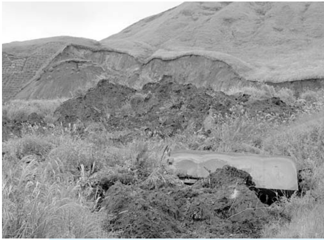
広範囲にわたって崩落した斜面
