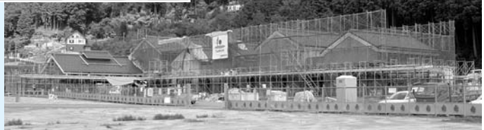
建設が進む道の駅「ようか但馬蔵」
