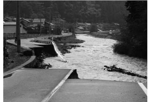
河川の増水で道路が流失（平成16年台風23号）
