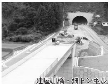
建屋川橋・畑トンネル
