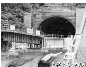
上谷トンネル
