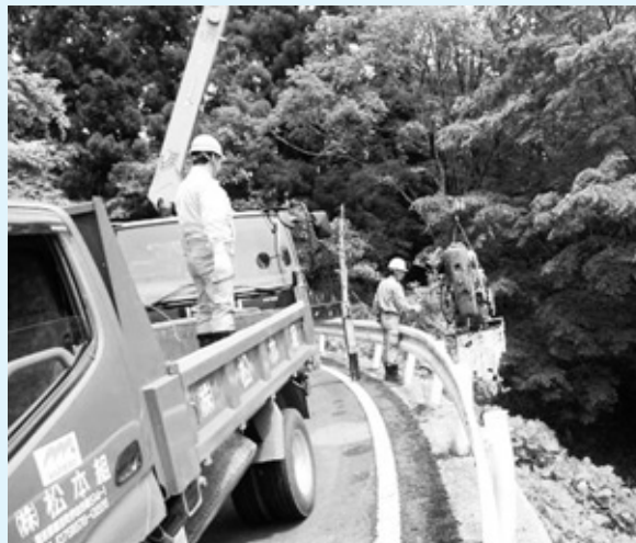
不法投棄ごみの回収作業
