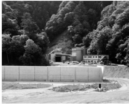
上谷トンネル
